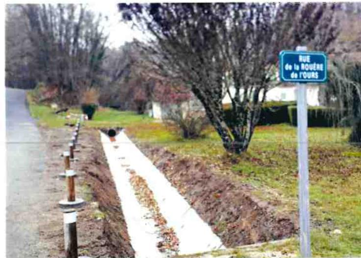
Pose de modules, par une entreprise, « Rue de la Rouère de L'ours », mise en place de potelets par nos agents pour sécuriser le bas-côté.
