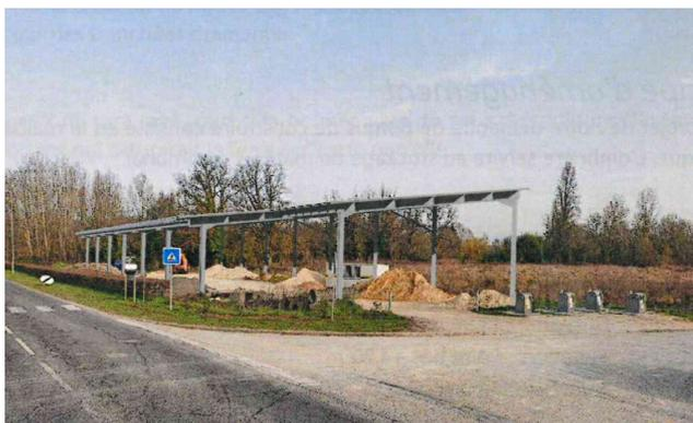
Ce projet comprend la pose d'une toiture de panneaux photovoltaïques d'une surface de 1163 m<sup>2</sup> (589 panneaux installés) d'une puissance de 238.5 kWc et d'une production d'électricité de 260,4 MWh / an.
